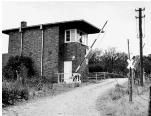
Bild 16: Der Bahnübergang ca. 1960
