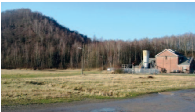
Bild 38: Fördermaschinenhaus u. Lüfter
